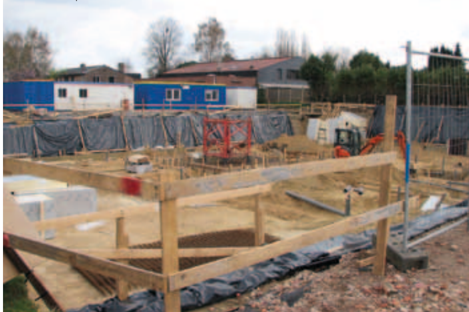
Bouw nieuw politiecommissariaat
